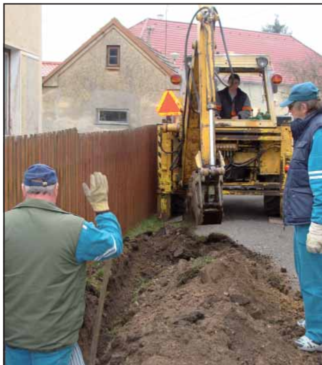
Výstavba nových bodů veřejného osvětlení v obci Vápenisko.
